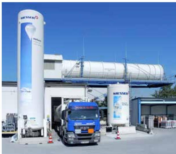
Réservoir de stockage couché d'une capacité de 120'000 l
